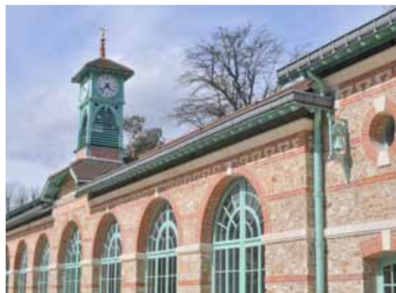
Vue extérieure des bâtiments en meulière
