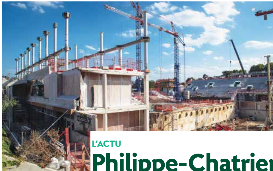
L'impressionnant chantier du court Philippe-Chatrier.
